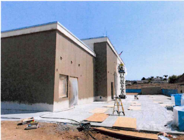
Tierra Del Sol – New Gymnasium
