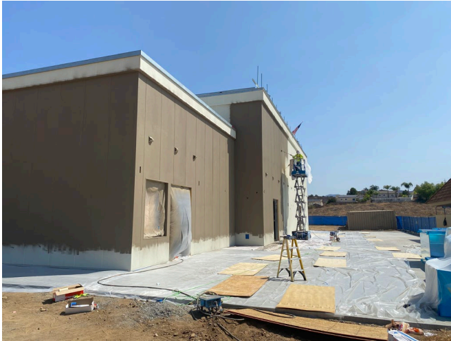
Tierra Del Sol – New Gymnasium
